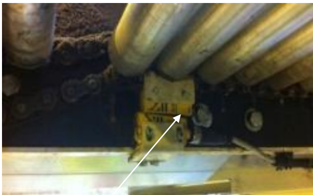
Figur 18: Induktiv givare satt ej i rätt position. Låg och skavde mot varandra, åtgärdades på plats.
