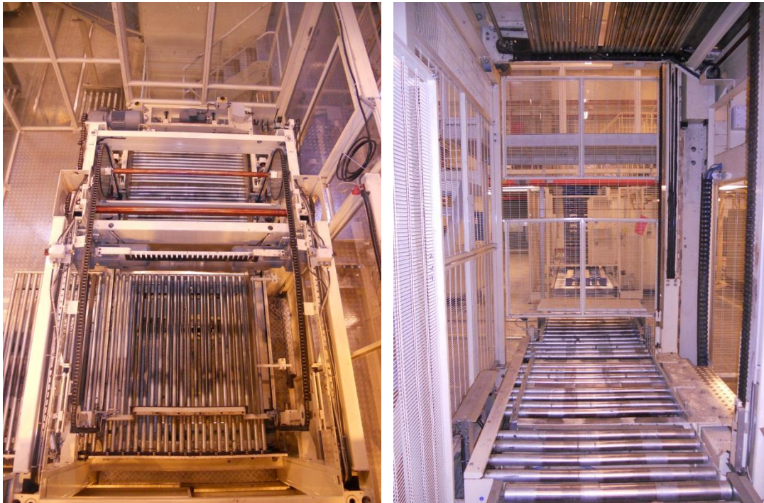
Figur 11: Palleteringsmaskin 3 sedd ovanifrån samt underdelen
