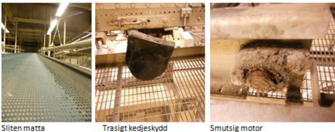
Figur 21: Exempel på defekter som upptäcktes vid initialrengöringen.
