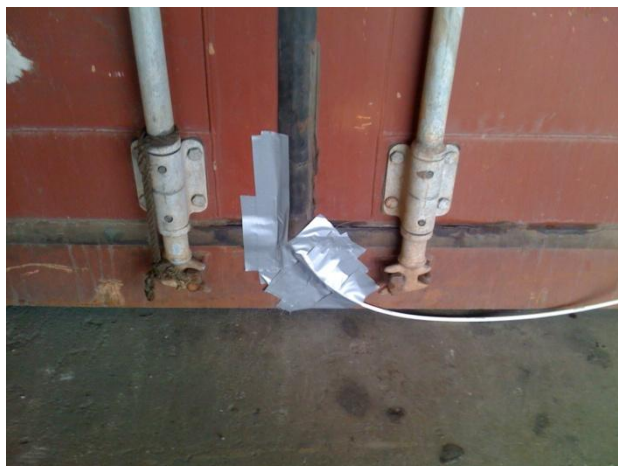
Figur 15. Området där ledningen äntrade containern tejpades ordentligt för att undvika läckage.
