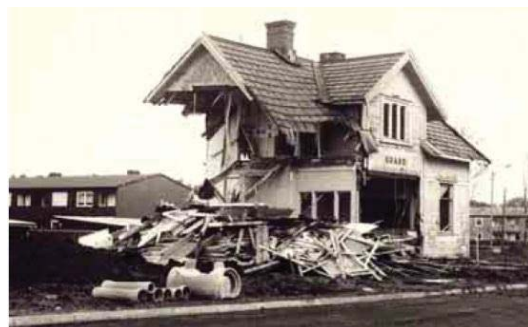
Figur 7: Rivning av stationshuset, ( www.lerum.se ).
