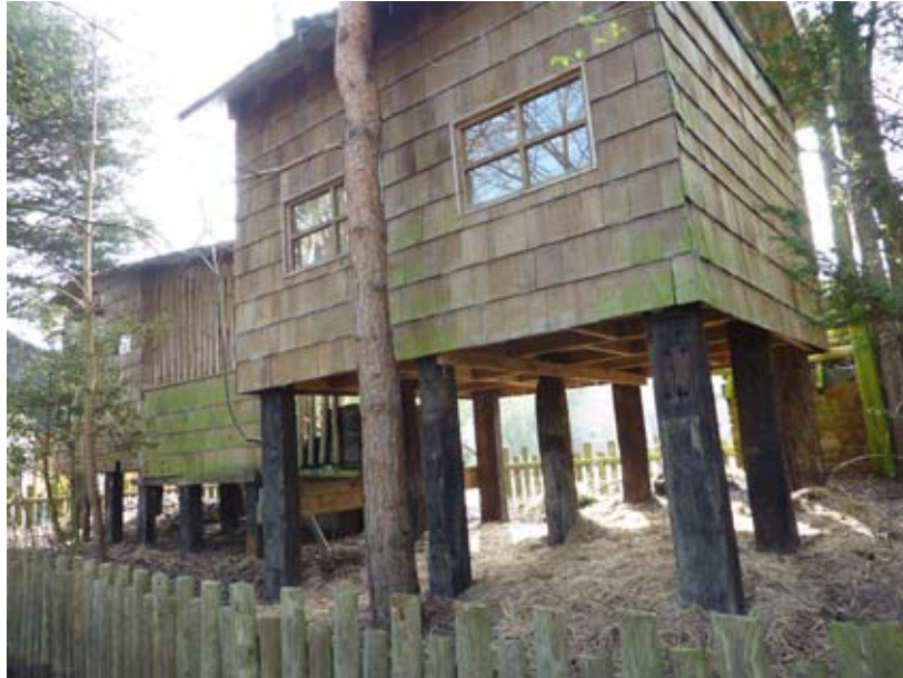
Utomhusklassrummet "Aspen Lodge"
