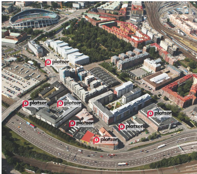
Figur 6. Platzers fastigheter i Norra Gårda. Ursprungsbild Eniro.se.
