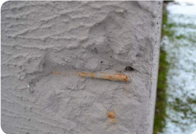
Grunderna på husen.
