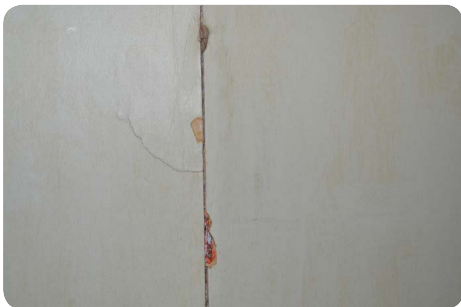
Sprickor har uppkommit i väggarna.
