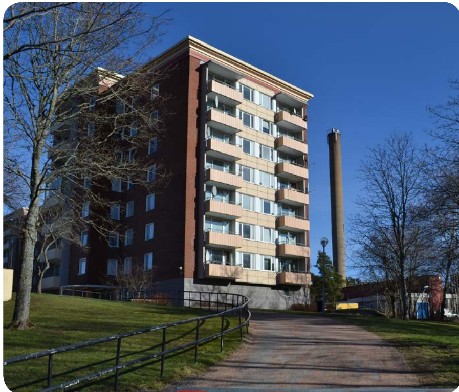
Bakom höghusen i Kronogården ligger ett av Trollhättans fjärrvärmeverk.
