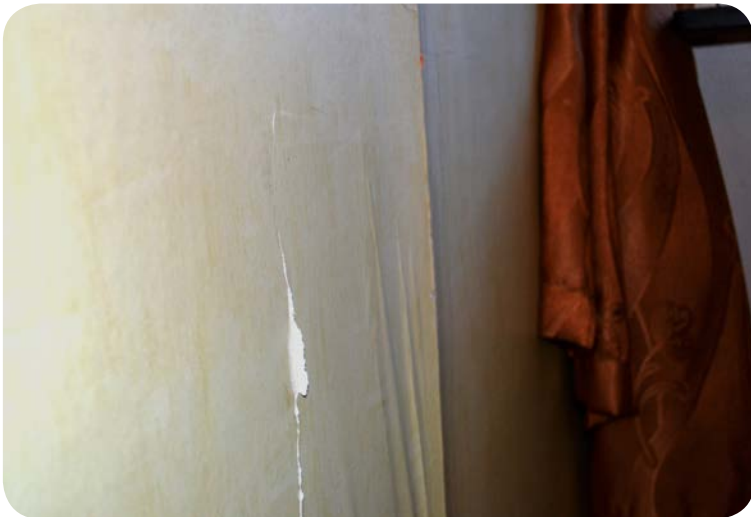
Innerväggar har skadats.
