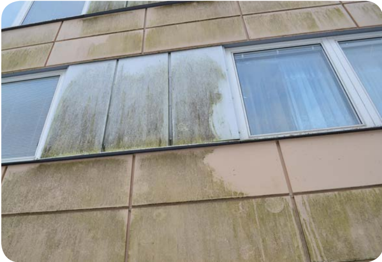
Bilden visar plåten på fasaden.
