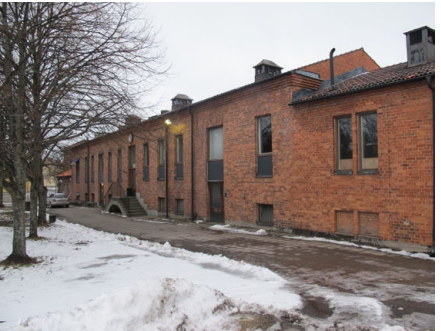
Tegelbyggnad i 2-3 våningar (4)
