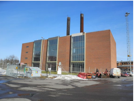
E.ONs kraftverk från tidigt 1970-tal (3)
