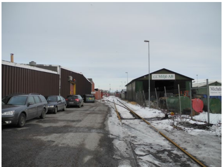
En diagonal spårväg skär genom området (6)
