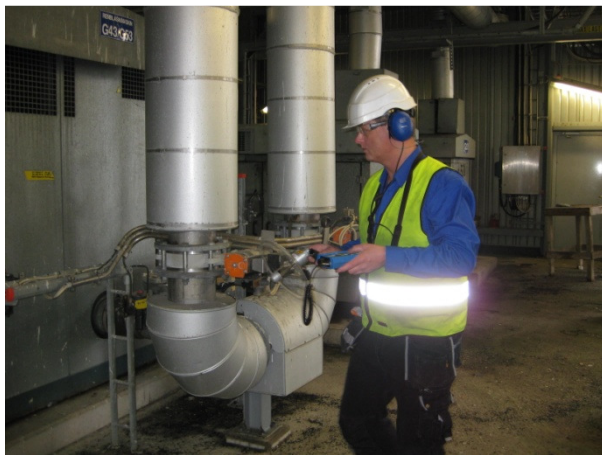
Figur 21 Utförande läcksökning Borealis
