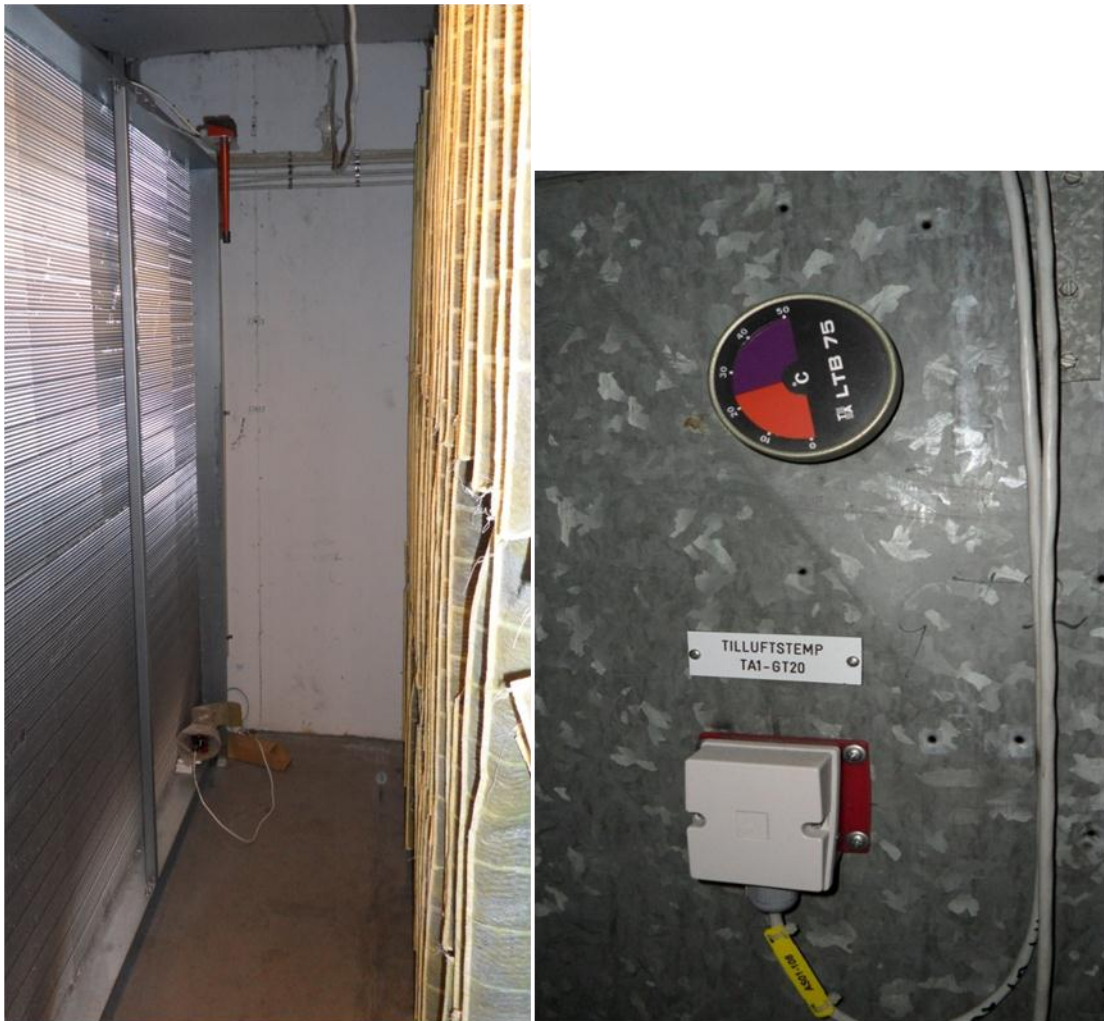
Figur 5a: Värmebatteri samt filter, Figur 5b: Tilluftstemperatur
