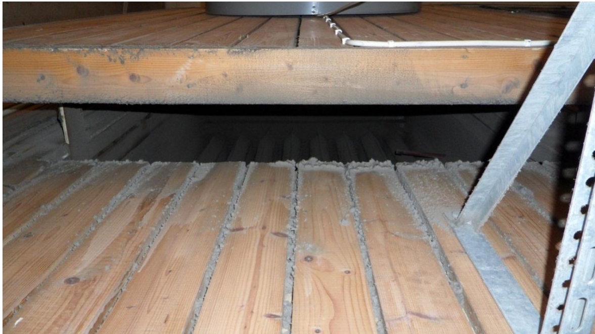
Figur 13: Återluftsintag bakom matchklockan
