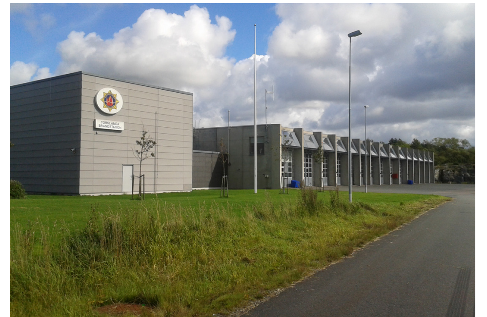
6. Brandstationens fasad mot Torslandsvägen. Här syns solcellerna ovanför portarna.
