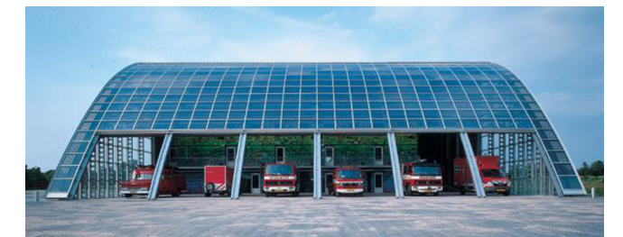
6. Bågformad i glas och stål i Nederländerna, Samyn and partners, 2000. Cirka fyra brandbilar kan staplas upp till takhöjden som ger en rejäl rymd. Hög grad av transparens i fasad och lekfull takform, ger en säregen brandstation.
