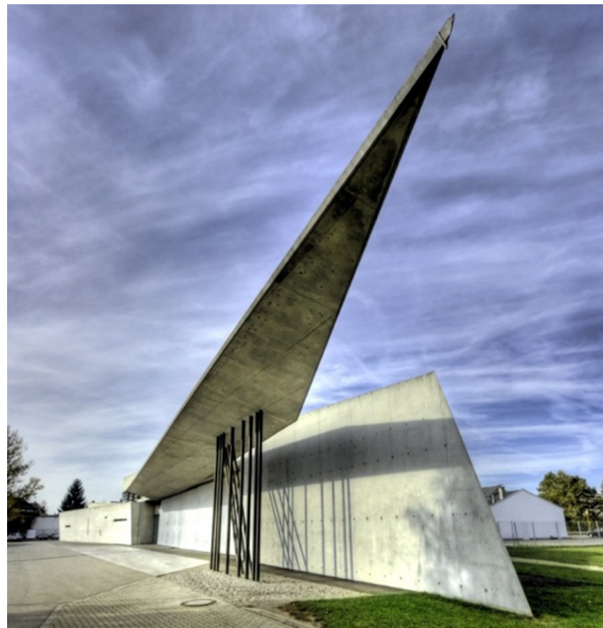
2. Vitra fasadens spetsiga vinklar i klar kontrast till vanliga rektangulära brandstationer. Inom Vitra området finns andra fräcka byggnader, däribland designmuseet ritat av Frank Gehry.
