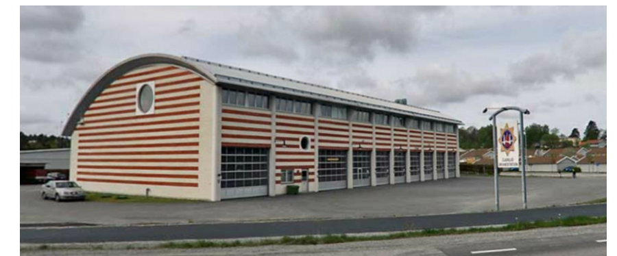
6. Öjersjö nya brandstation med ett lätt bågformat tak.
