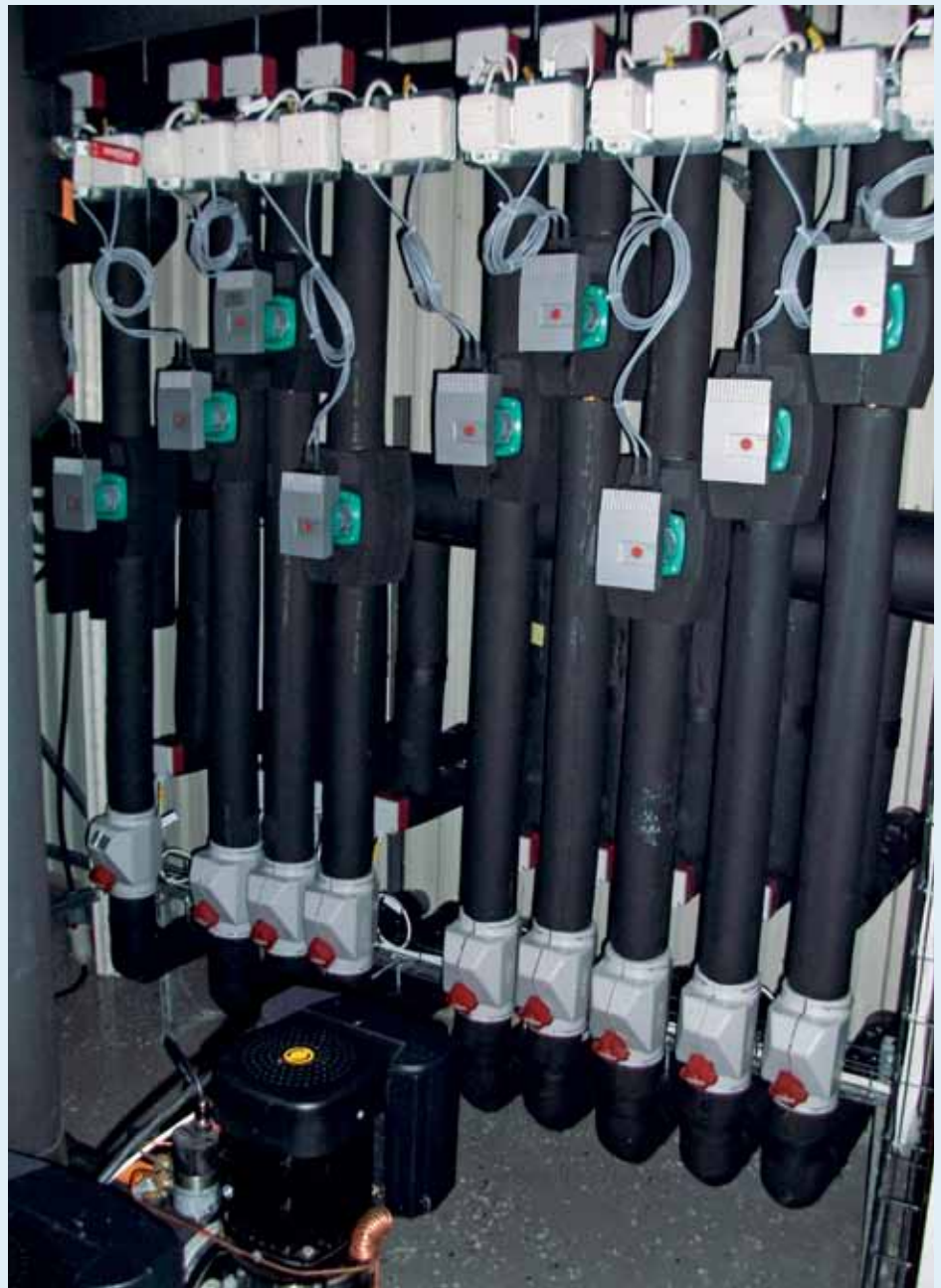
Figur 3: Individuella, varvtalsstyrda pumpar för samtliga nio borrhål.
