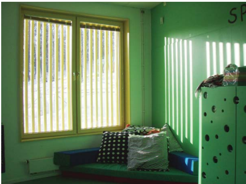
öppningsbart fönster med raster utanför
