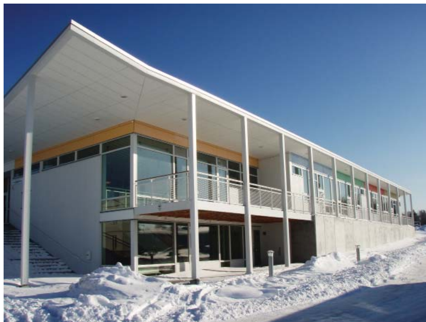
trappan upp till huvudentrén och den gemensamma ateljéen på hörnet
