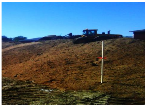
Figur 13. Stakkäpp med flukt vid vägbygge utanför Skövde (egen bild vid praktik hos NCC).
