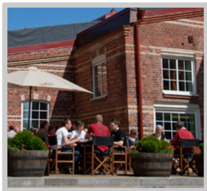
Bild 22: Ett levande område i Krokslättis fabriker där de anrika byggnaderna blir hem till nya verksamheter. Foto: Husvärden AB
