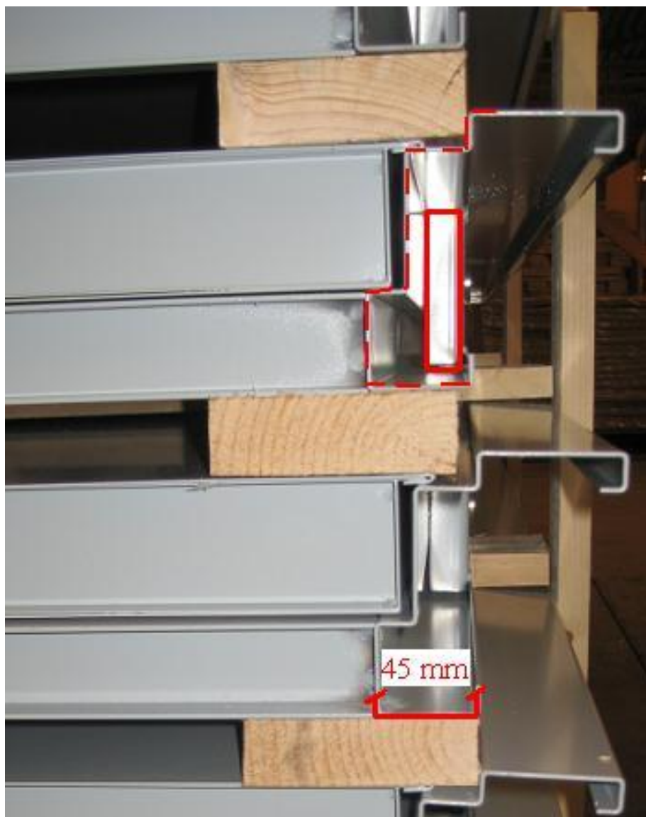
Figur 5.2 Visar att kontaktytan som upptar tryck är 45 mm bred på den sidan av distansen där dörrkarmen har kontakt. Andra sidan på distansen har kontakt med dörrbladet. Där är kontaktytan lika stor som distansens yta. De streckade strecken är dörrkarmen i profil och de heldragna, rektangulära sträcken är förstärkningen.
