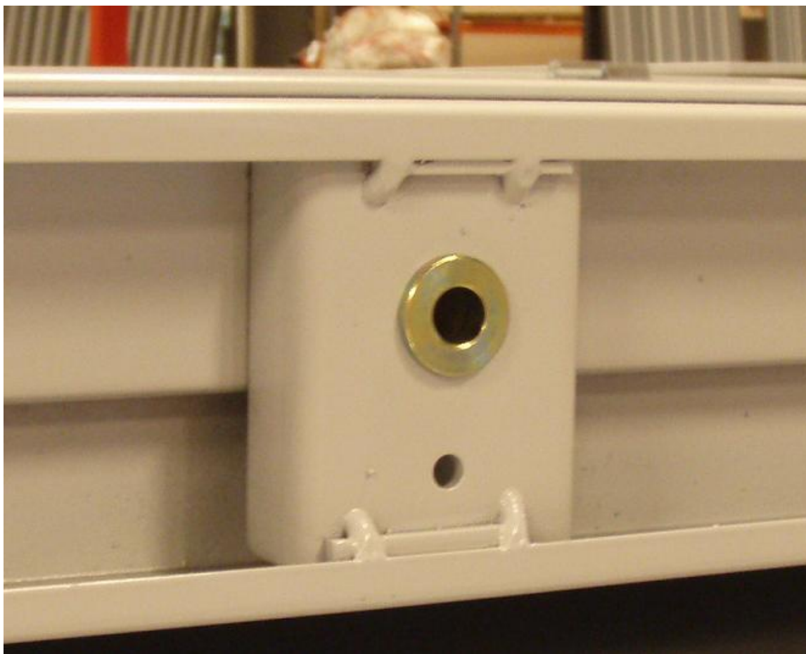
Figur 5.3 Visar förstärkningen som sitter i karmen (röda rektangeln i föregående bild)
