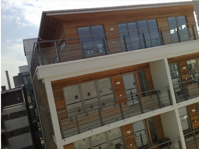
Figur 25: Referensobjekt, puts och cederträ. Br. Erlandsson Bygg & Allservice AB (2008)
