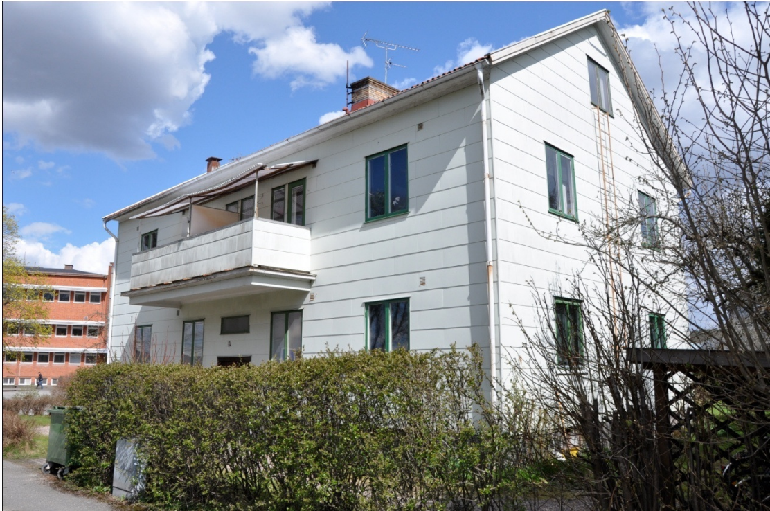
Figur 6.2 Bofinken 1, fasad mot idrottsgatan.
