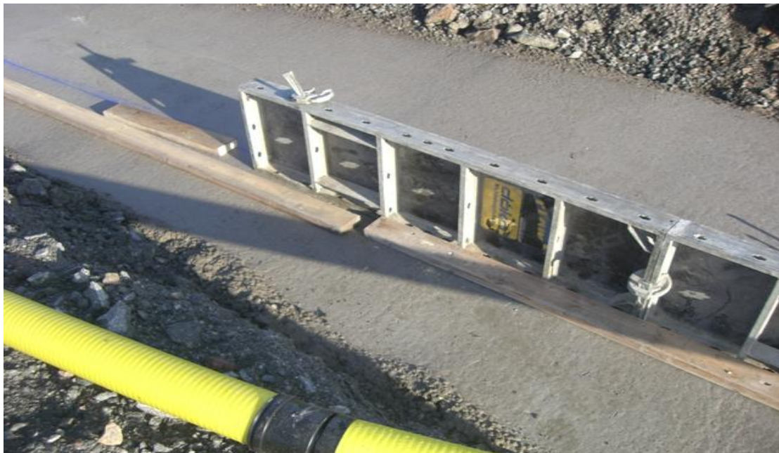
Bild 3 Dokaformskonstruktion, en formvägg förankrad i skyddsbetong Foto: C, Andersson (2010)
