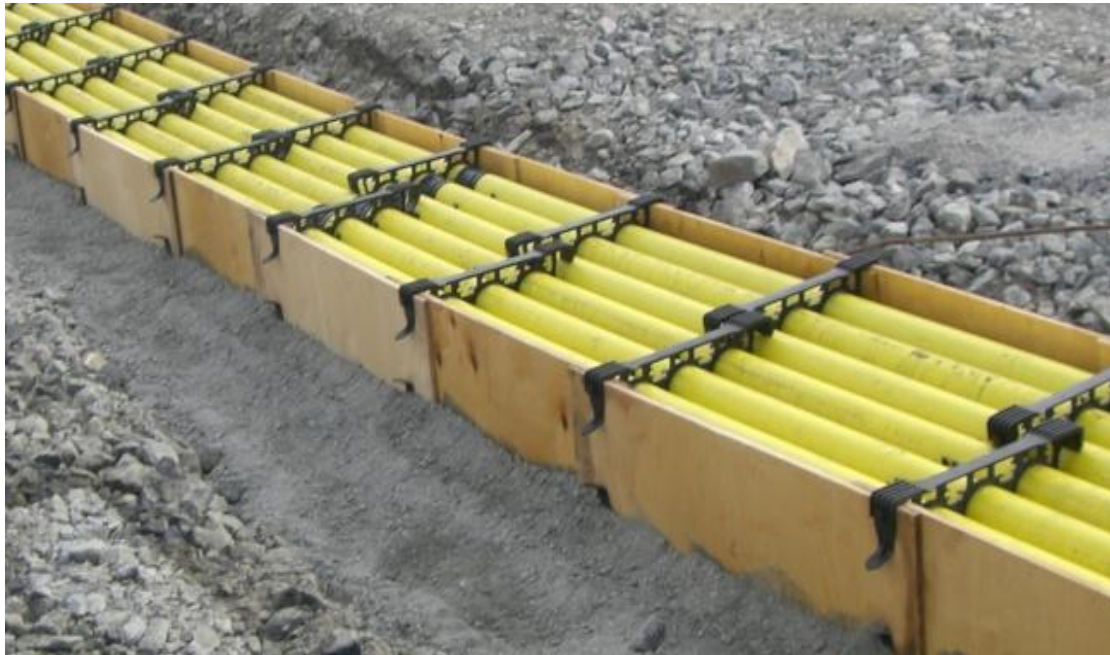
Bild 4 OPI-konstruktion. De övre plastdistanserna slås sönder vid rivning av form. Foto C. Andersson (2010)
