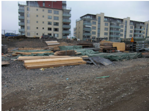
Bild 2. Materialupplag ute på byggarbetsplatsen.
