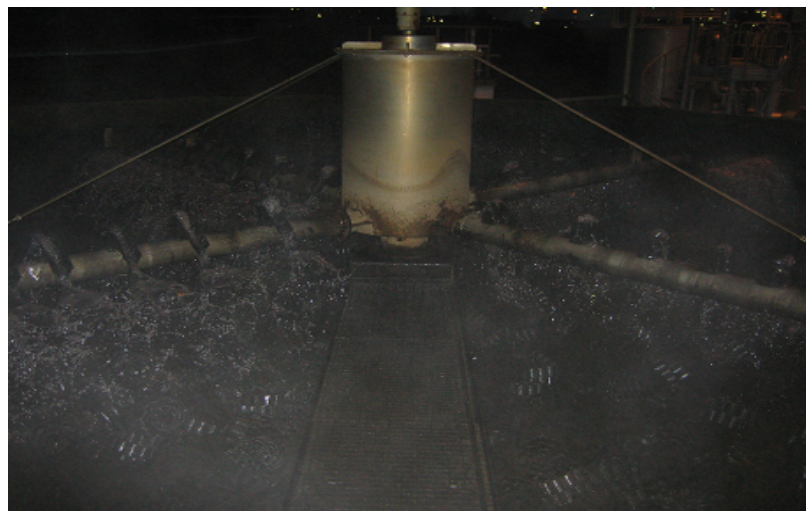
Figur 5. Spridararmen fördelar vattnet över fyllkropparna med bakterier.
