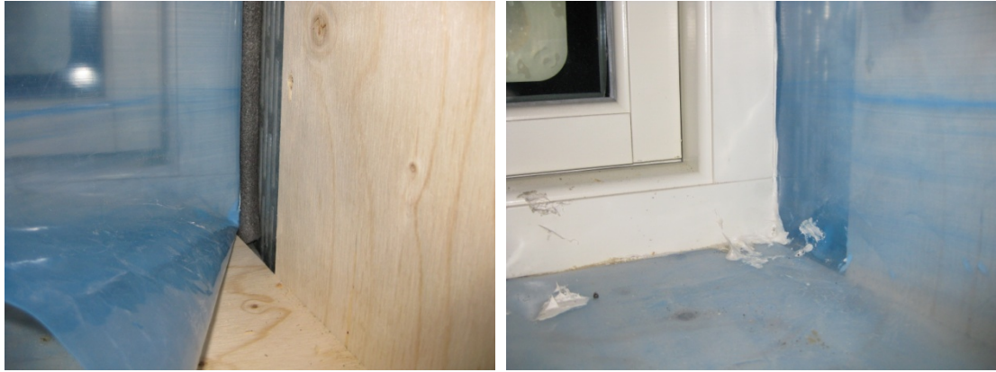
Figur 26a och b. Fönsteranslutning från Ellös. Figur a visar en bottningslist som placeras i hörnet mellan karm och smyg, bakom plastfolien. Plastfolien viks sedan över bottningslisten och Figur b visar den mjukfog som lagts i skarven mellan karm och plastfolie (Misteröd, 2007).
