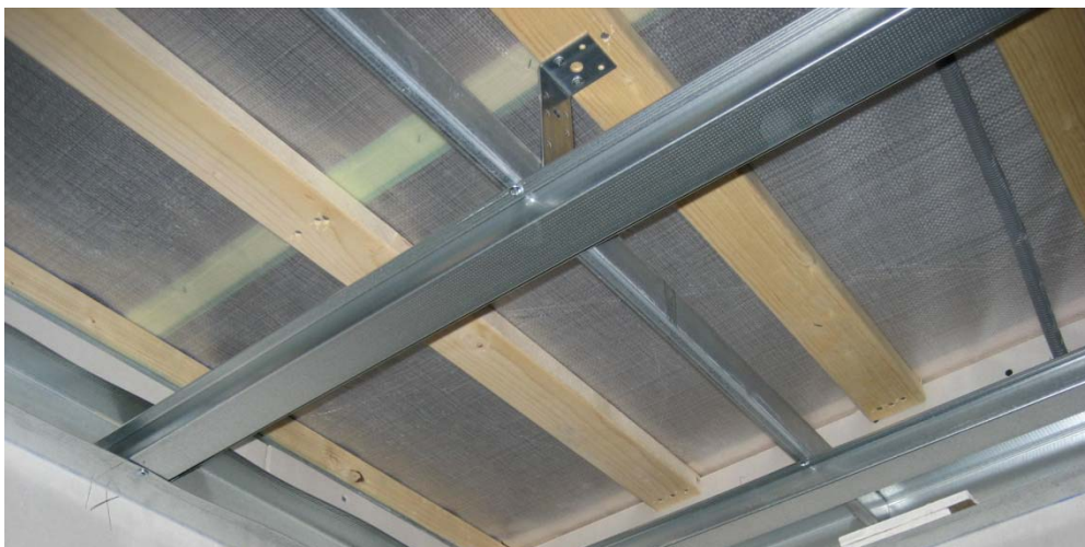
Figur 13. Nerpendlat undertak med plats för installationer (Misteröd, 2007).
