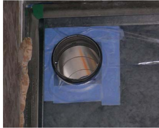
Figur 12a och b. Figur a visar en elgenomföring med stös, den här bestående av flexibel EPDM-duk med tejp som tejpas mot plastfolien. Figur b visar en genomföring utan stös med en extra bit plastfolie som tejpas både mot tätskikt och mot rör (Wahlgren, 2010).
