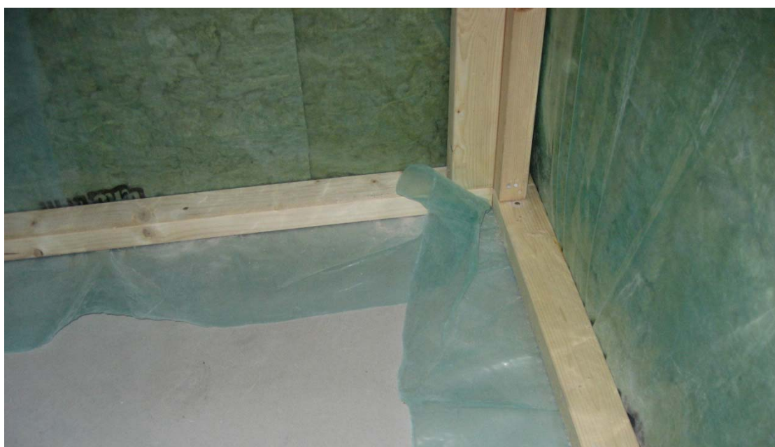
Figur 21. Exempel från Misteröd där plastfolien är klämd under syllen med butylgummi och senare även fogad mot betongen. (Misteröd, 2007).
