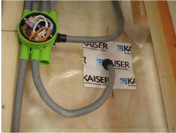
Figur 12a och b. Figur a visar en elgenomföring med stös, den här bestående av flexibel EPDM-duk med tejp som tejpas mot plastfolien. Figur b visar en genomföring utan stös med en extra bit plastfolie som tejpas både mot tätskikt och mot rör (Wahlgren, 2010).
