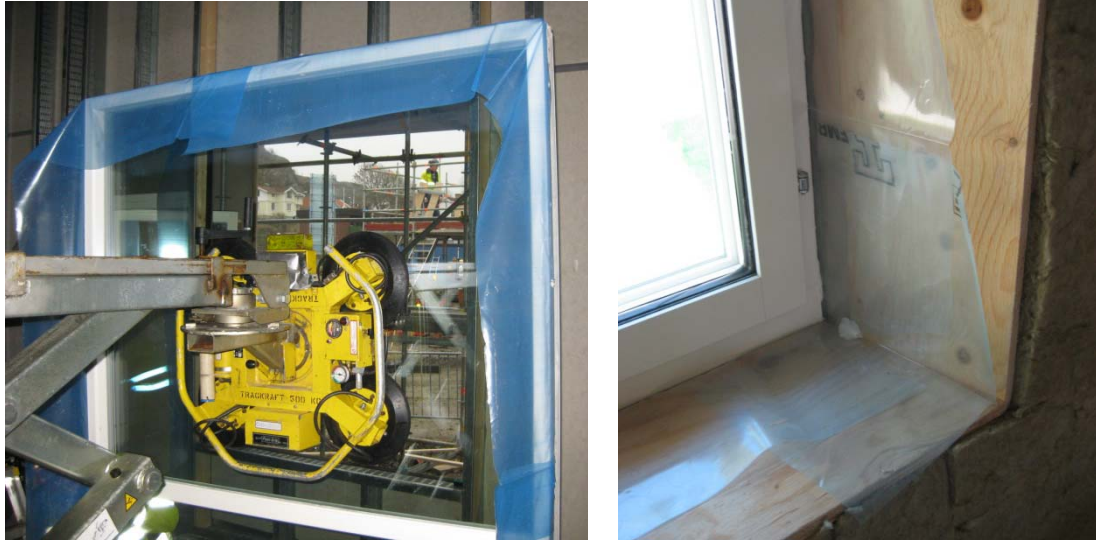
Figur 24a och b. Figur a visar plastfolien som är fastsatt på fönsterkarmen före monteringen av fönstret (Ellös, 2009). I Figur b är fönstret monterat och kompletterande plastfolie i fönsterhörn är på plats (Misteröd, 2007).
