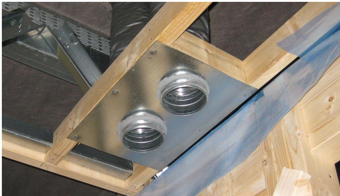
Figur 11. Genomföringar för ventilationskanaler utförda med plåtstos i Misteröd. Figuren visar plåtstosen som är ansluten till ventilationskanalerna, före plastfolien är monterad. Därefter monterar plastfolien och kompletterande tätning sker med mjukfog (Misteröd, 2007).
