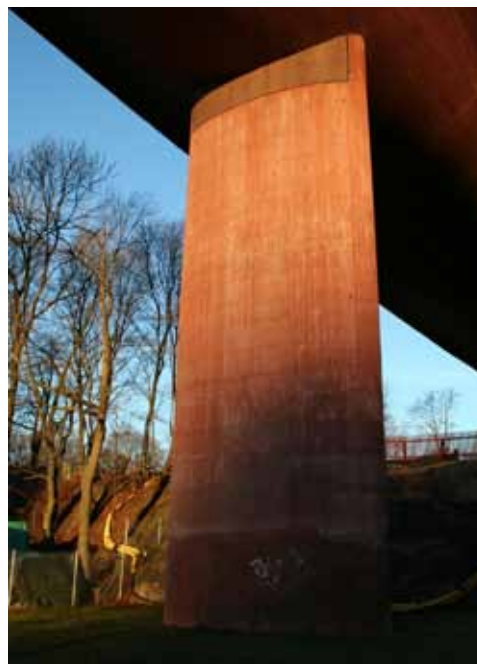
70. Betongpelare med röd infärgning Pelaren bär upp Årstabron i Stockholm. Bild: EnDumEn
