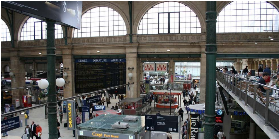
Gare du Nord, ett våningsplan har byggts med hjälp av metallkonstruktioner för service och kommersiella verksamheter.
