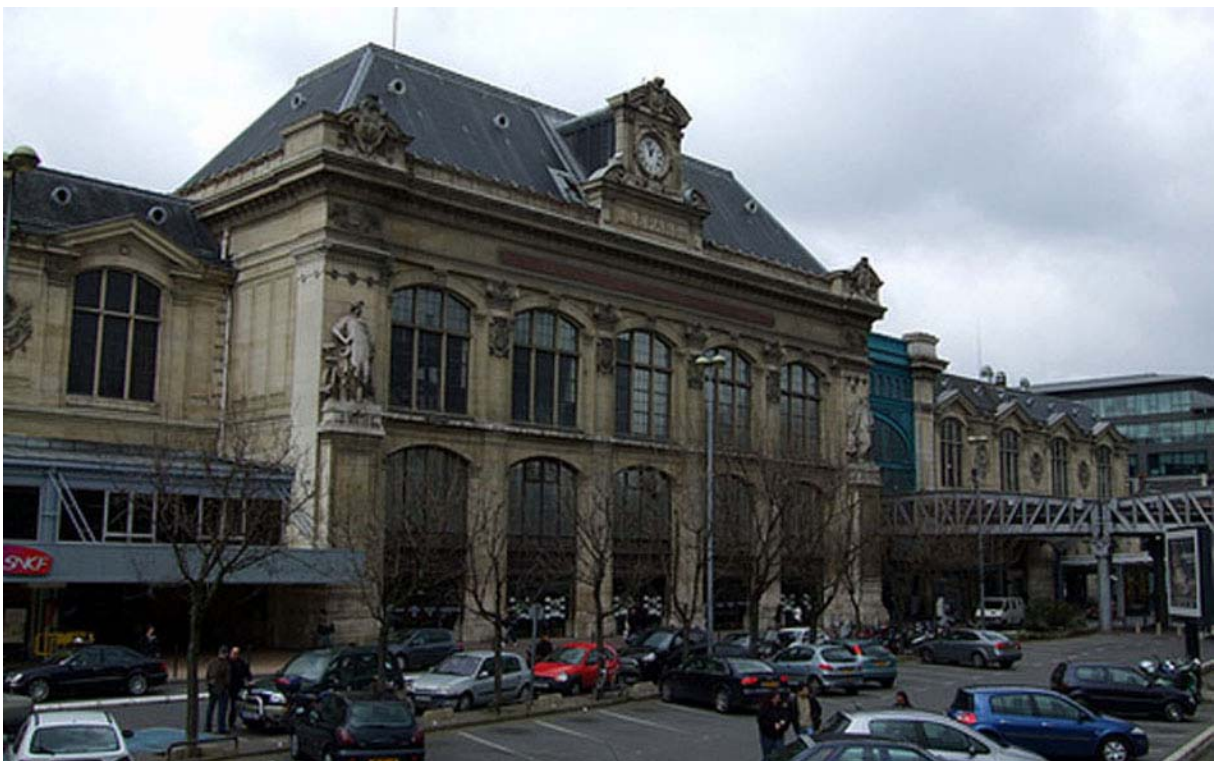
Gare d'Austerlitz, dagens utseende.
