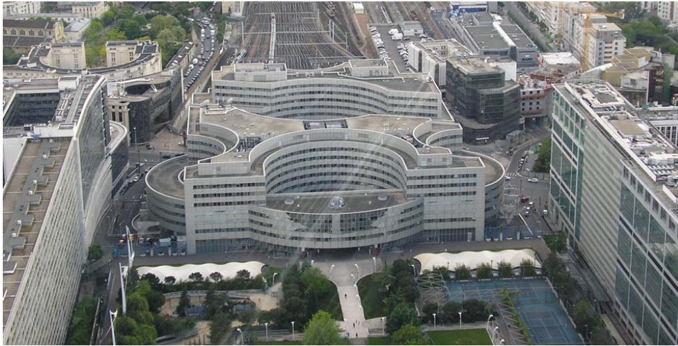
Gare Montparnasse, överdäckningen av bangården skapar ett användbart område.
