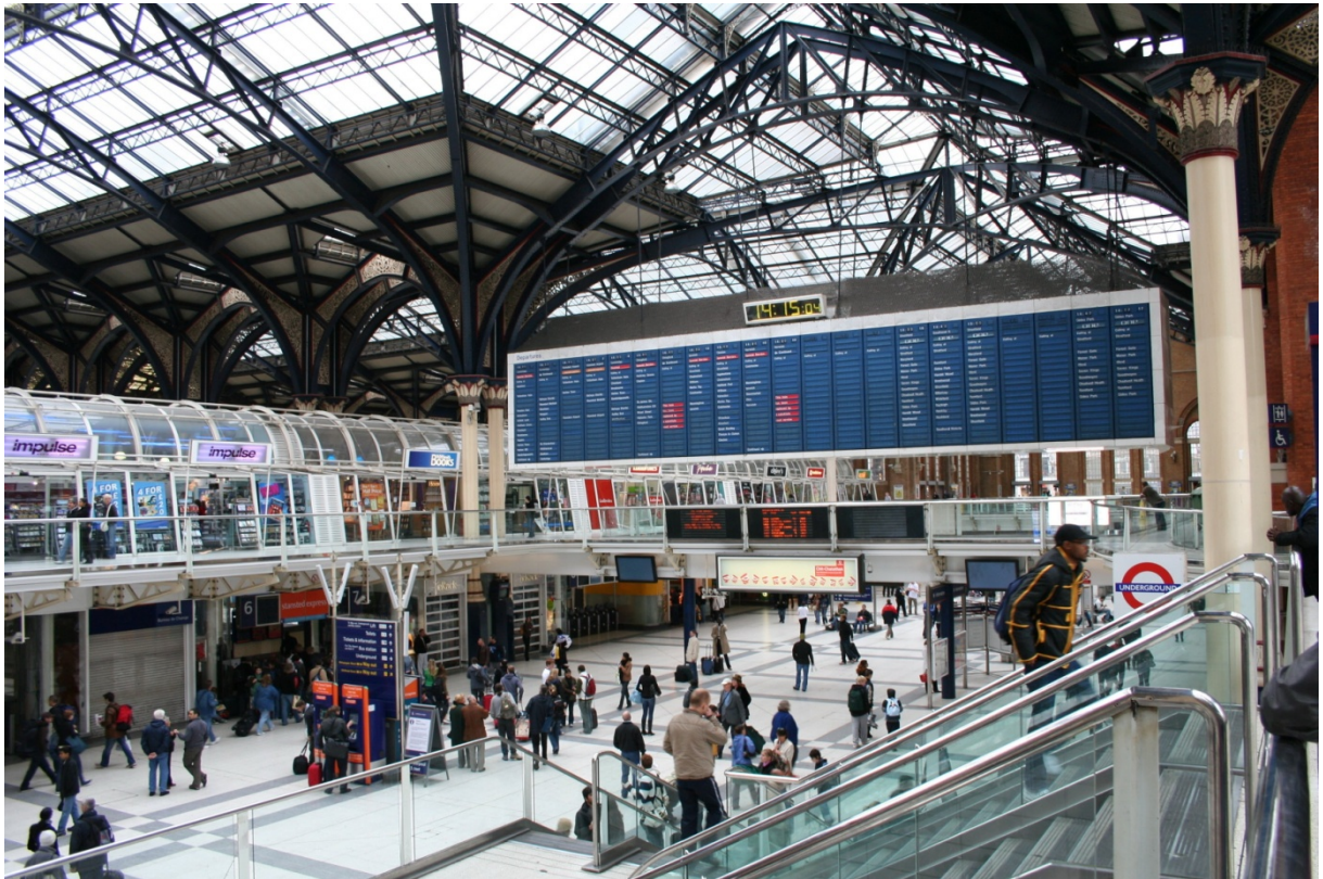
Liverpool Street station, en stål- och glaskonstruktion mitt i stationens stora hall.
