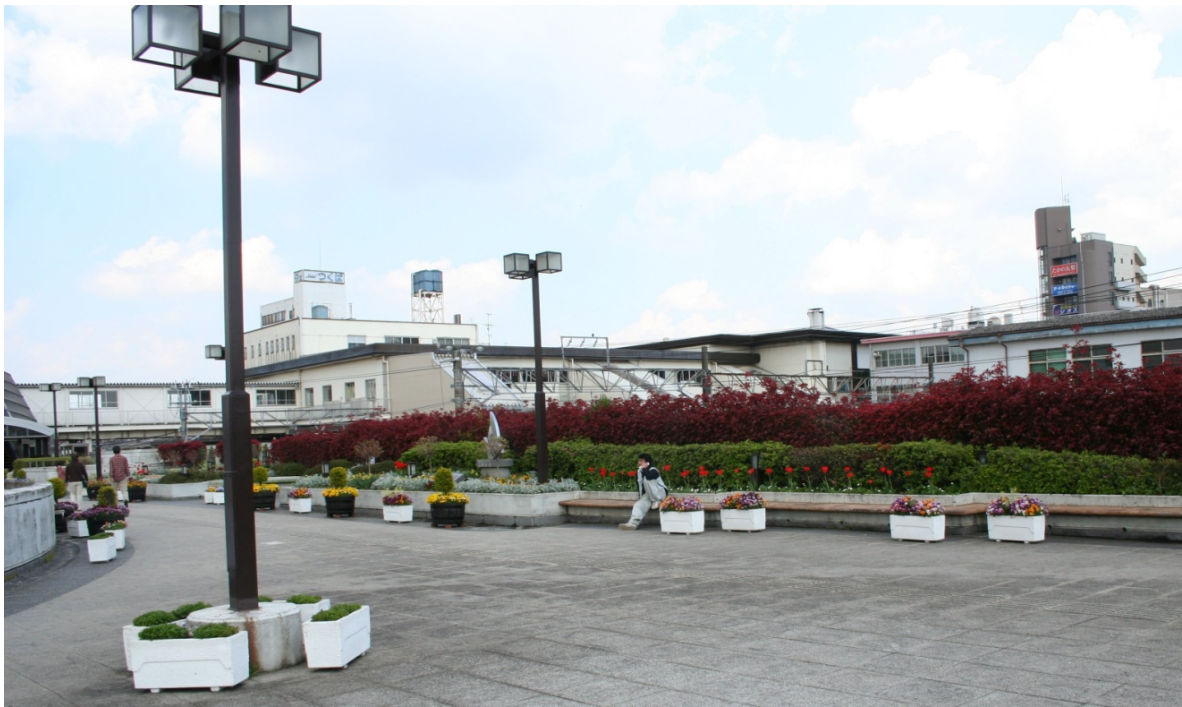
Narita station, terrassen kopplar västra sidan med den östra.
