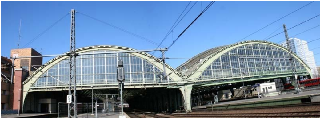
Ostbahnhof, spåren är täckta av två bågformade metallkonstruktioner.
