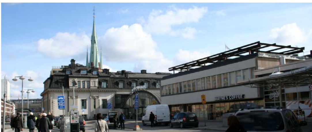
Stockholm C, ingången från Klarabergsviadukten.
