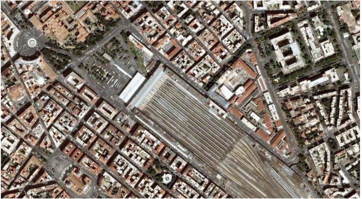
Stazione Termini – flyfoto.
