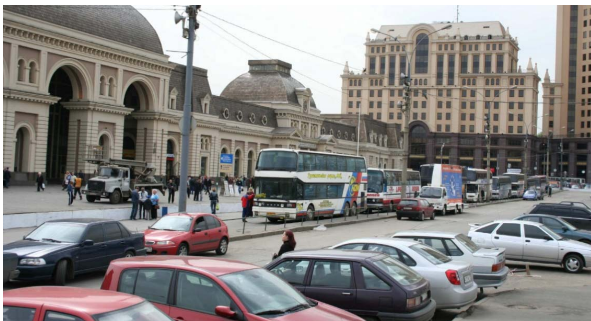
Paveltskij Vokzal, huvudentrén med hållplats för långfärdsbussar och parkering.
