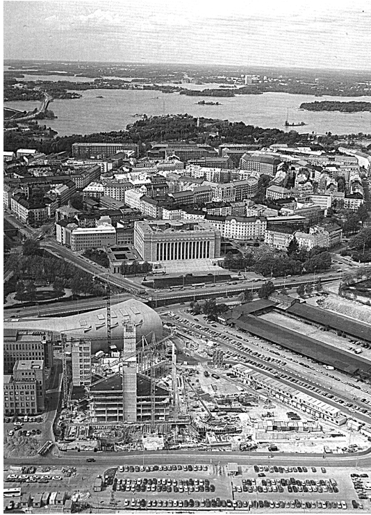
Bild 9: Parlamentsbyggnaden. Mannerheimvägen. Kiasma. Sanoma-huset under konstruktion i förgrunden. Tävlingstomten till höger. Järnvägens två lagerbyggnader.
