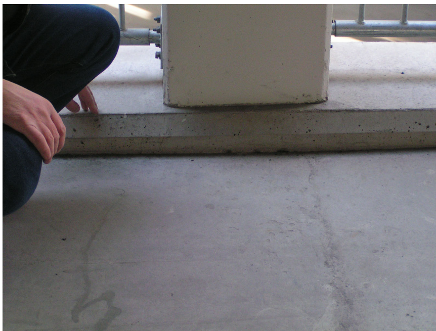
Figur 3.7 Sprickbildning ovkant bjälklag, KV Koffen/Göteborg.
