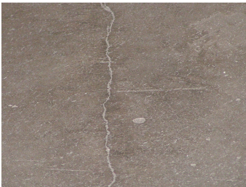
Figur 3.8 Regelbunden spricka på ovansida bjälklag, Ericsson/Göteborg.
