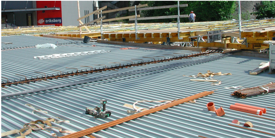
Figur 2.2 Plannja Combideck, armeringplåt som tillsammans med platsgjuten betong bildar ett samverkansbjälklag, Eriksberg/Göteborg. Foto: Per Hilmersson.
